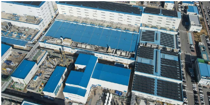
광양 양극재 공장 태양광 발전 설비
